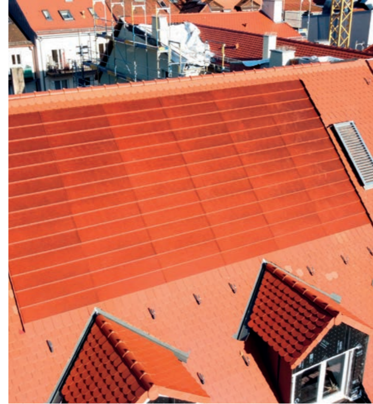
Planum PV in rot mit Biberschwanzeindeckung in naturrot bei Sonne
