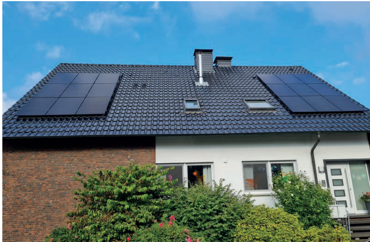
Aufdach-PV System
