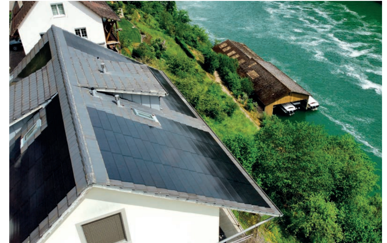
G10 S PV mit G 10 in anthrazitgrau engobiert, Sanierung: ca. 50 m² bestehende Ziegel ausgedeckt und mit G10 S PV Module eingedeckt
