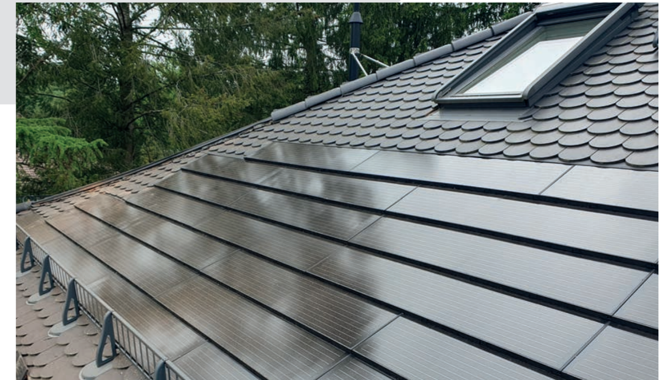
Planum PV mit Biberschwanz in braun, während der Verlegung
